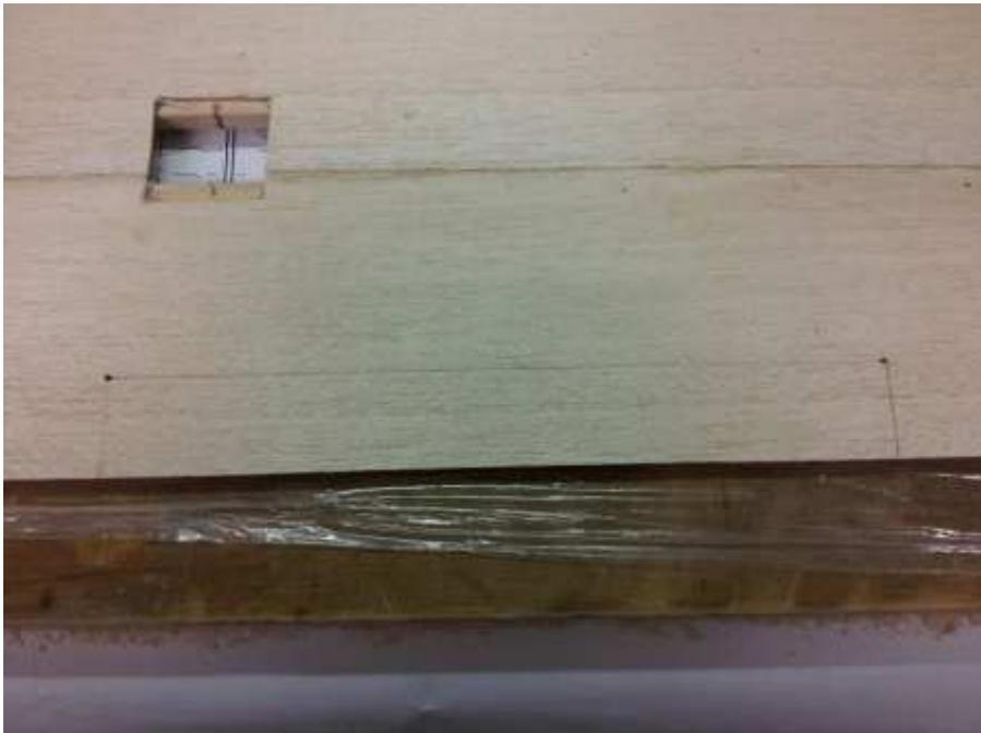
Poncer en biseau au niveau du bord de fuite, afin que les deux planches de coffrage inférieur et supérieur se joignent parfaitement sans toucher au profil.
