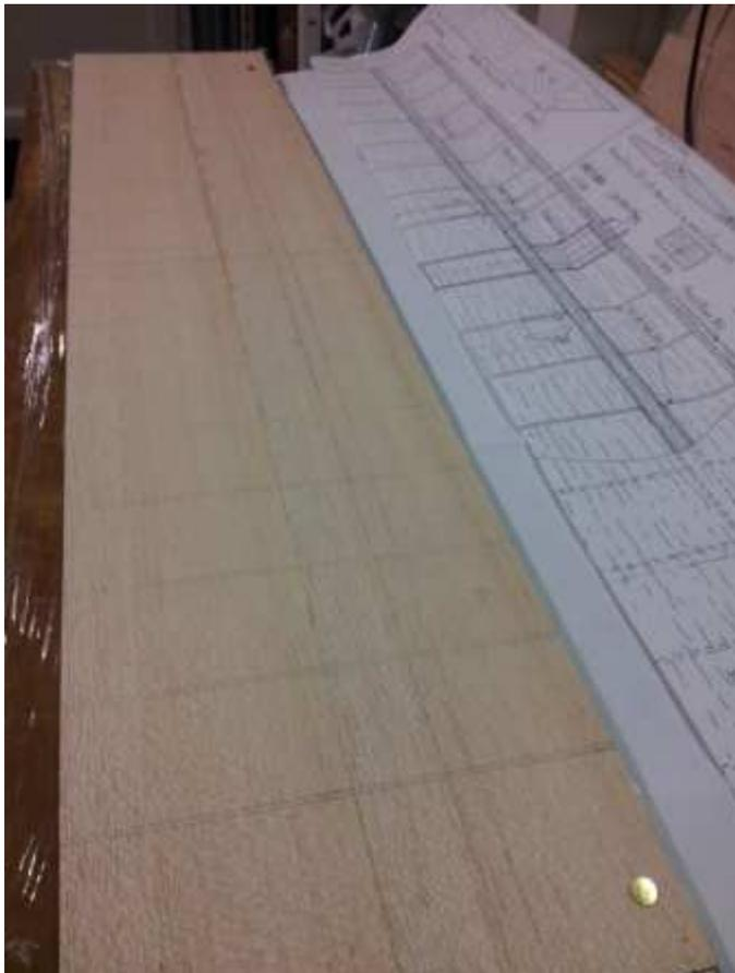
Préparer le calage du bord d'attaque et du bord de fuite, afin que le coffrage inférieur épouse parfaitement la nervure :
